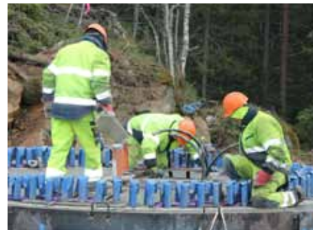
Gjutning av fundament i Rödshöjdens vindpark (20 MW) i Lappland. Foto: OX2.
