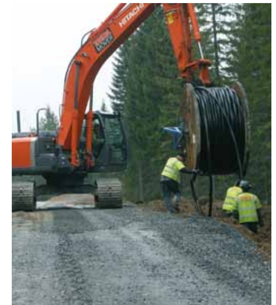
Nedläggning av elkabel. Foto: OX2.
