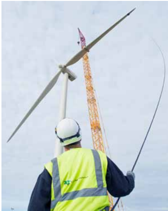
Byggnation av vindkraftverk kräver stor precision. Tornet och maskinhuset monteras först för att sedan lyfta och montera vingarna. Foto: Patrick Miller, OX2.
